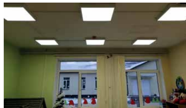
Nr. 40. Po renowacji instalacji elektrycznej – nowoczesne oświetlenie LED
