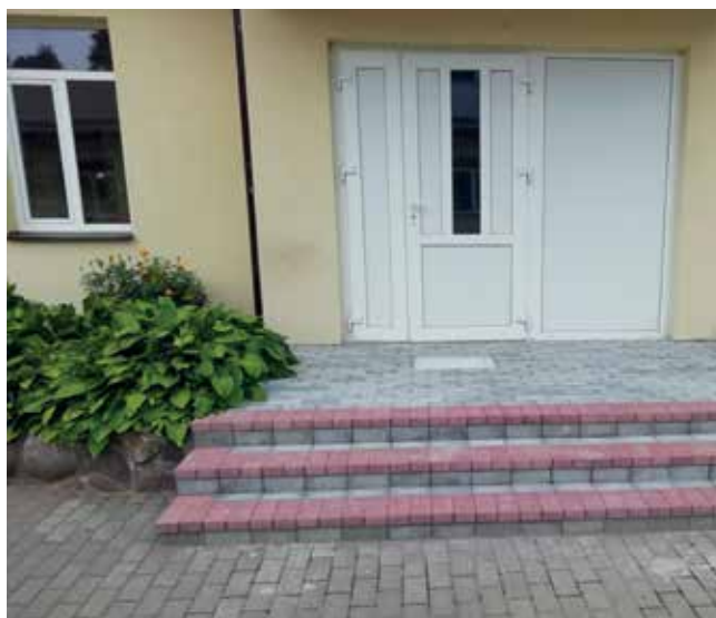
Nr. 39. Schody wejściowe po renowacji. 2021 r.
